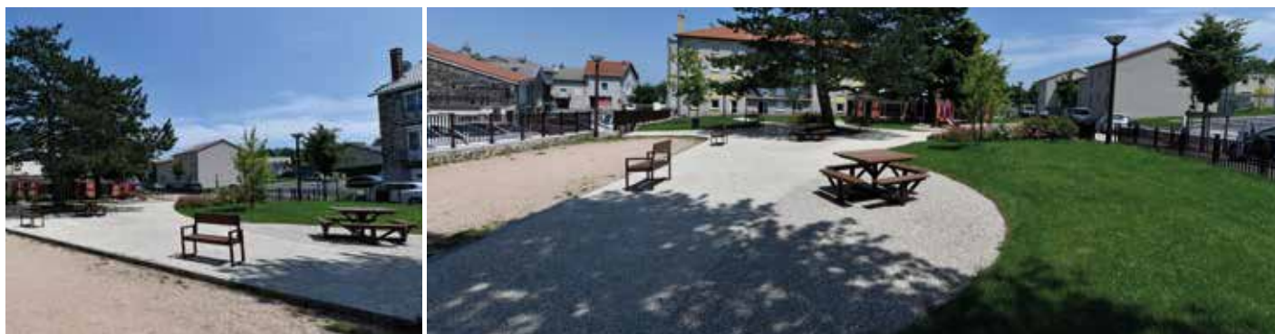
Yssingaux : travaux et aménagement du Quartier de Pompée
