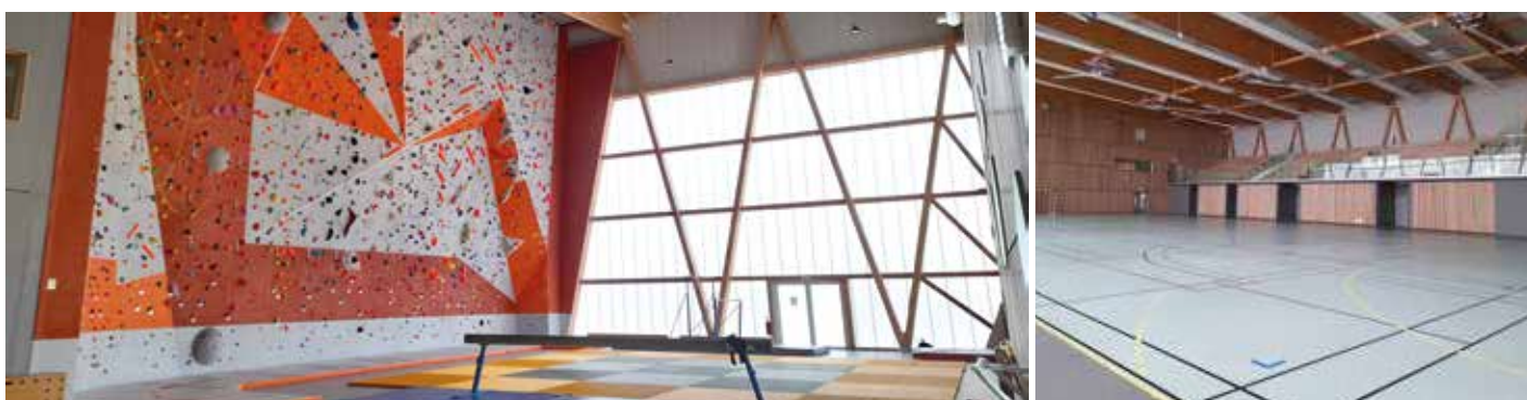
Retournac : travaux et aménagement du gymnase avec la création d'un mur d'escalade
