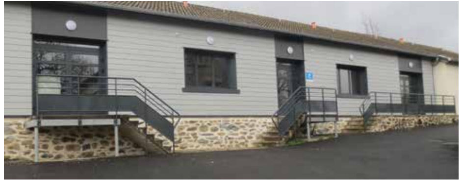
Araules : réhabilitation de l'ancienne colonie à Recharinges en salle multi-activités.
