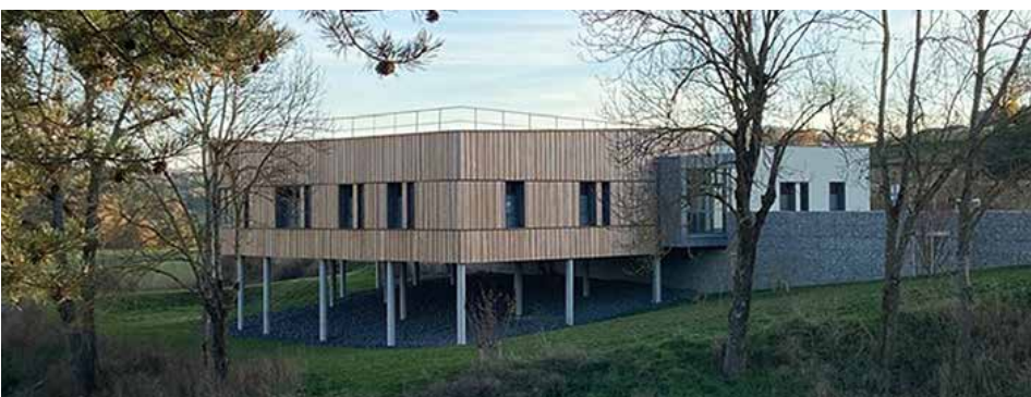
St-Maurice-de-Lignon : travaux à la salle des fêtes et sur le mausolée
