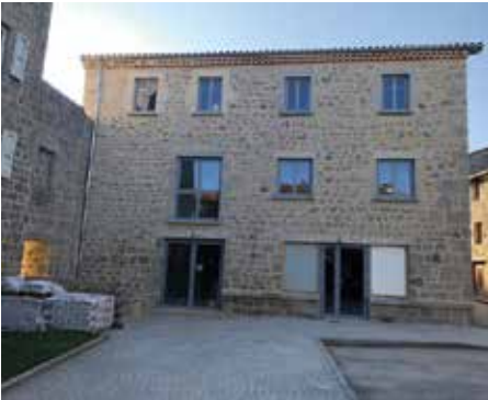
Grazac : travaux à la salle multi-activités
